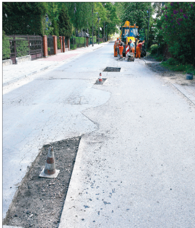
Gwarancyjne naprawy nawierzchni podczas budowy kanalizacji sanitarnej (ul. Stawowa, Kontrakt 4).
