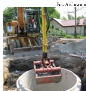
Posadowienie pompowni PN 45.2. metodą studniarską (Etap II, Zadanie 4).
